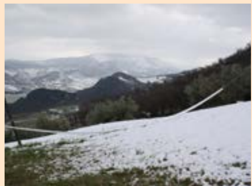
Contrada Bufalara - uno dei cavi elettrici a terra per il peso della neve
